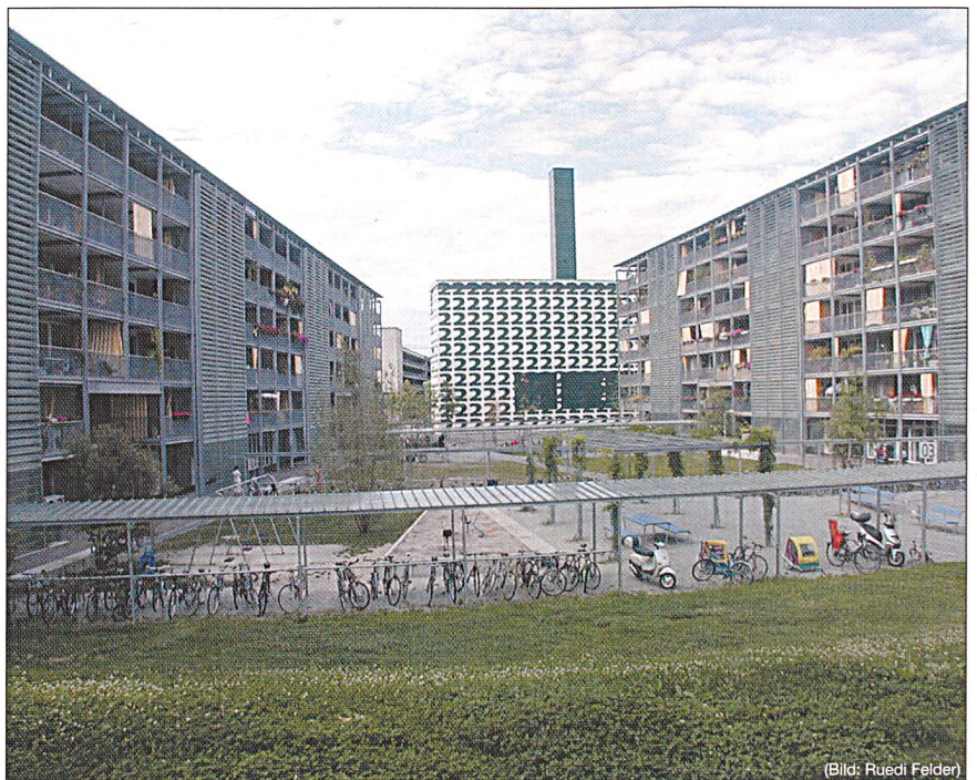
Bild 5 Ansicht der Überbauung Regina-Kägi-Hof Im Hintergrund ist das Fernheizwerk sichtbar.
