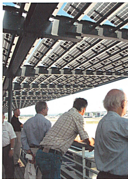
Blick von der neuen Besucherterrasse des Docks E. In die Bedachung ist eine Photovoltaikanlage integriert.
