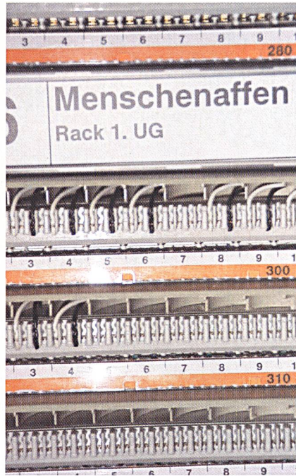
Anschlussleisten VS 83 einer Bucht in der TVA (Teilnehmervermittlungsanlage) Hicom 300
