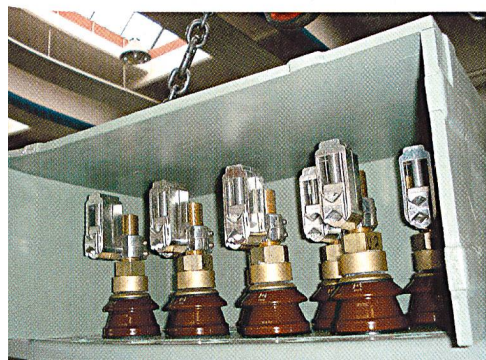
Bild 8 US-Abdeckhaube für 1000-kVA-Transformator.
