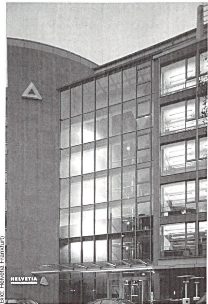
Bild 1 Ansicht der Süd-Ost-Fassade des Bürotrakts Das Bürogebäude liegt in der Frankfurter Weissadlergasse, unweit Römers und Dom.
