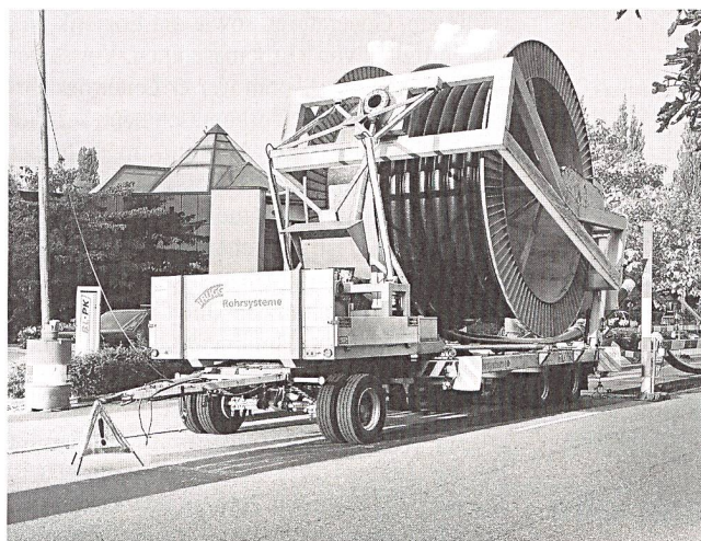
Flexible Fernwärmeführung vor der Montage, Bild links.
