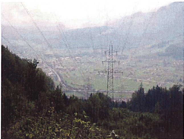
Lukmanierleitung an der Stelle des Baumüberschlages (Bild Etrans).
