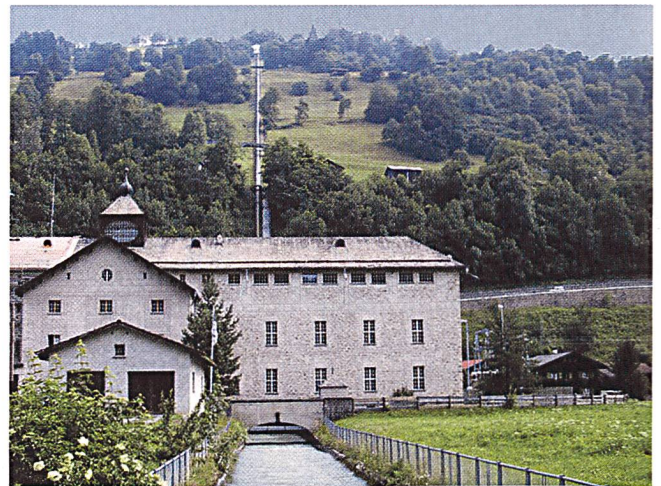
Der grosse steinerne Technikbau der Zentrale Küblis steht in den Wiesen vor dem Dorf Küblis (Bild: Rätia Energie).
