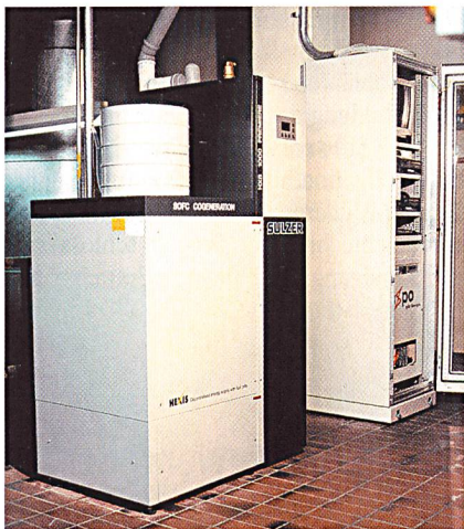
Die Brennstoffzellen-Heizanlage von Sulzer Hexis: Pilotversuch im virtuellen Einfamilienhaus. Aus Wasserstoff und Sauerstoff wird Wasser, Strom und Wärme (Bild: axpo).
