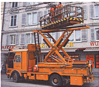
Geschützt wie der Vogel auf dem Drahtseil: Auf dem bis 1000 Volt isolierten Turmwagen dürfen sich die Techniker – zumindest im Trambereich – sicher fühlen.
