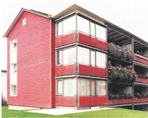
Minergie-Haus Waidmatt in Zürich (Bild: minergie).
