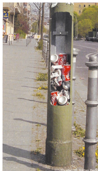
Bild 1 Zweckentfremdung der Lichtmasten
