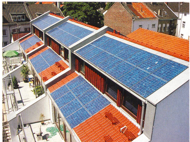
Dafür gibt es in Deutschland viel Geld: PV-Dachanlage.
