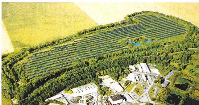
Projektmontage des Solarstrom-Kraftwerks bei Leipzig (Bild Geosol).
