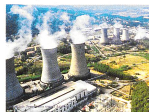
Centrale geotermoelettrica Larderello-Travale (487 MW/foto Enel).
