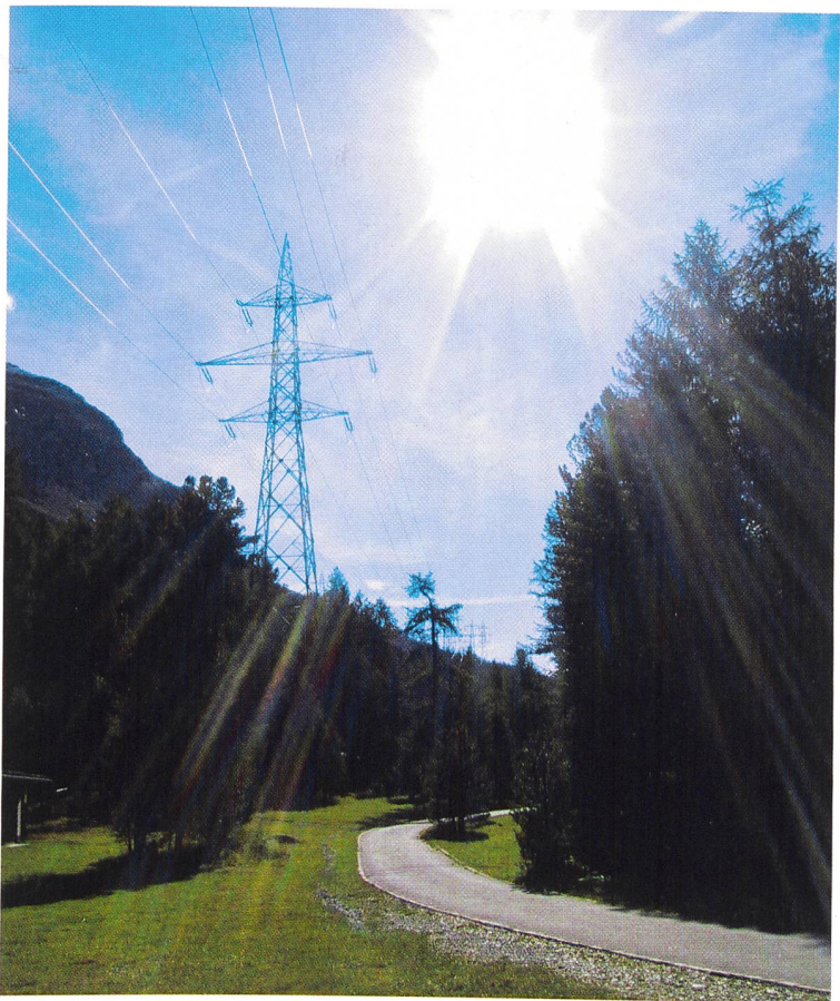
Freileitung der Rätia Energie bei Pontresina.
