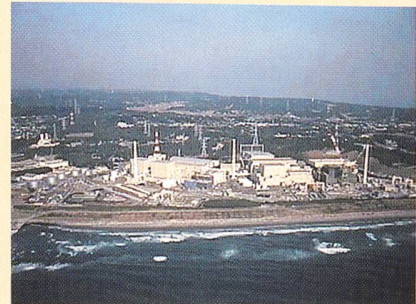
Kernkraftwerk Hamaoka an Japans Südküste.
