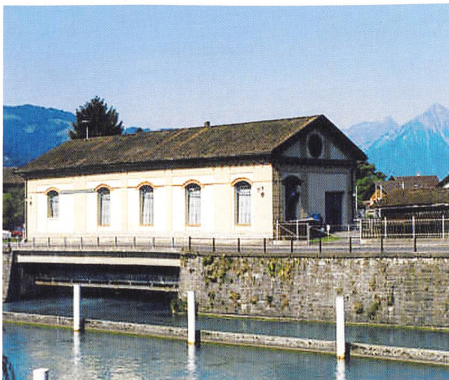
Altes Elektrizitätswerk der Industriellen Betriebe in Interlaken (Bild: IBI).
