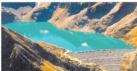
Tiwag-Kraftwerk Sellrain-Silz (Bild Tiwag).
