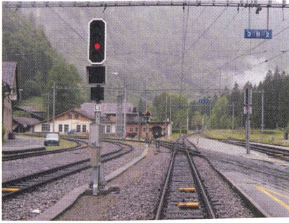
Zugsicherung auf der Strecke Interlaken Ost (Bild: BOB)
