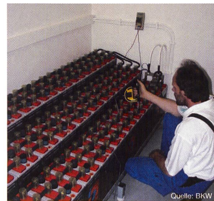
Bild 1 Messung der Säuredichte
