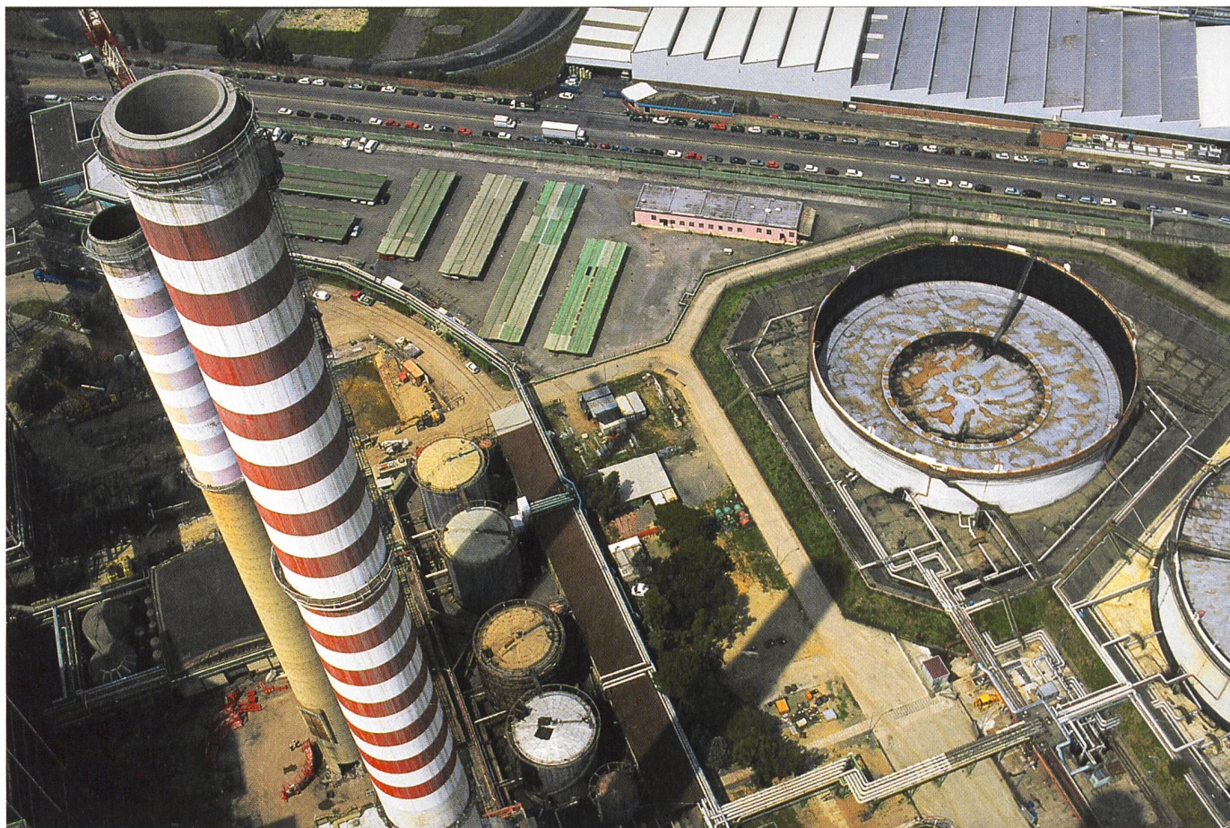
Ein erheblicher Teil der thermoelektrischen Leistung des Landes basiert auf Erdöl, das immer teurer wird (thermoelektrisches Kraftwerk La Spezia/Foto Enel).
