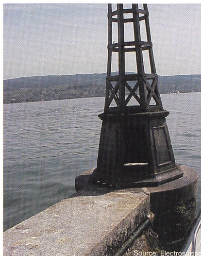
Figure 7 Vue du lieu de l'accident
