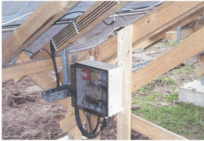
Photovoltaik-Ableiter Dehnguard von Elvatec
