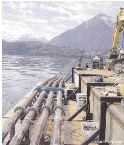
Bild 6 Der Rohrblock wird auf dem Thunersee zusammengestellt und abgesenkt
