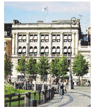
Gebäude der EUA in Kopenhagen.
