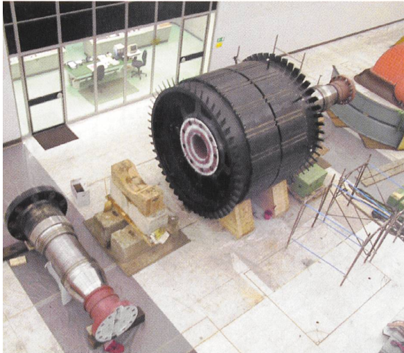
Ersatz von Generatoren im Wasserkraftwerk Biasca (TI).
