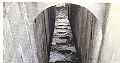
Fischpass im Rheinkraftwerk Eglisau.
