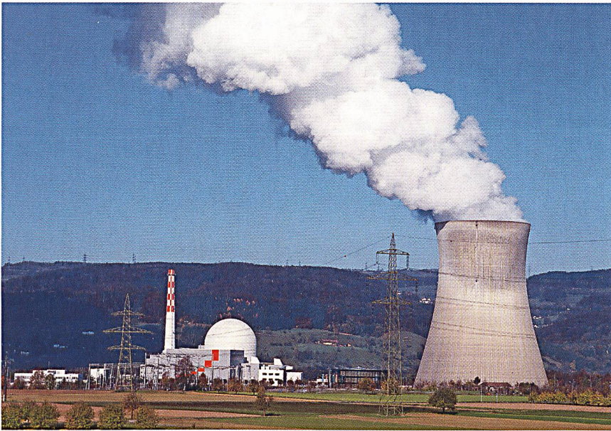
Kernkraftwerk Leibstadt mit neuem Anstrich (Bild: kkl).
