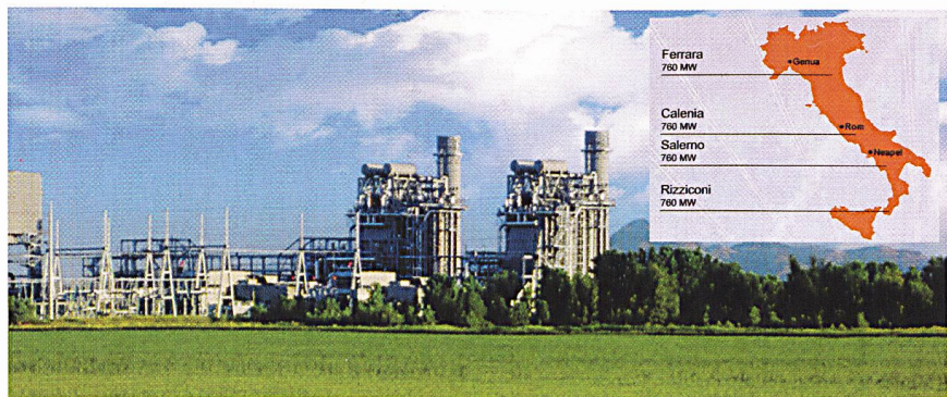
Axpo Holding AG investiert in vier italienische Gas-Kombikraftwerken in Ferrara, Calenia, Salerno und Rizziconi (Bilder: axpo).
