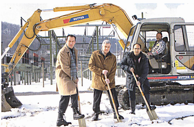
Spatenstich auf dem Baugelände in Sulgen. V.l.n.r.: Urban Kronenberg, Direktor EKT; Edwin Wirth, Leiter Anlagenbau; Maurizio Balletta, Planung/Bauleitung Hochbau.
