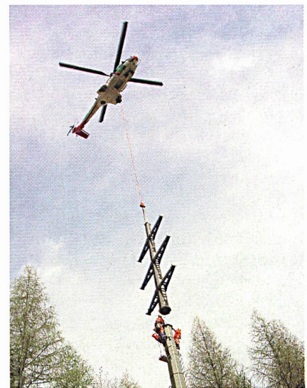
Aufstellen eines Strommastes mit Helikoptereinsatz (Bilder: sak).
