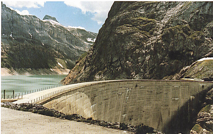
Die Bogenstaumauer des Limmernsees speichert bis zu 92 Millionen Kubikmeter Wasser (Bild axpo).
