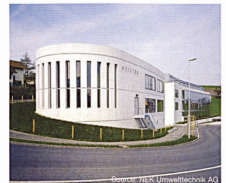
Figure 7 Usine et bureaux à Wollerau, Schwyz, chauffés et refroidis par un champ de 32 sondes géothermiques
