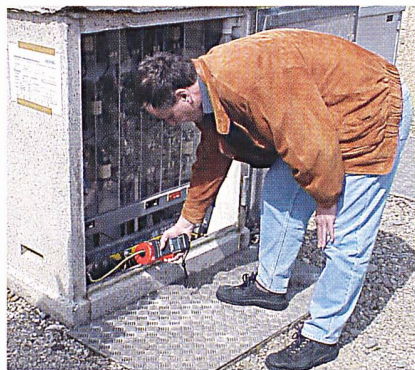
Erdungsmessung in Verteilkasten.
