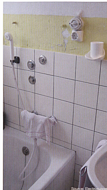
Cette prise de courant n'est pas conforme aux prescriptions de l'OIBT (la distance de la baignoire doit être d'au moins 70 cm)
