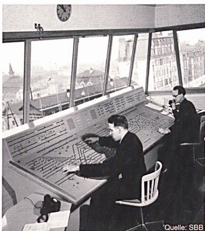
Bild 5 Relaisstellwerk Lausanne: Domino 1955 mit Zwergsignalen und Fahrstrassenspeicher, in Betrieb seit 1963
