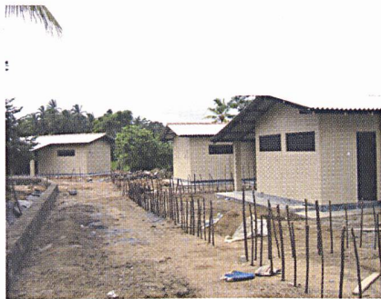
La reconstruction du village de Pitiduwass
