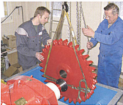
Montage de la roue Pelton dans la centrale hydraulique sur le réseau d'eau potable de Sachseln
