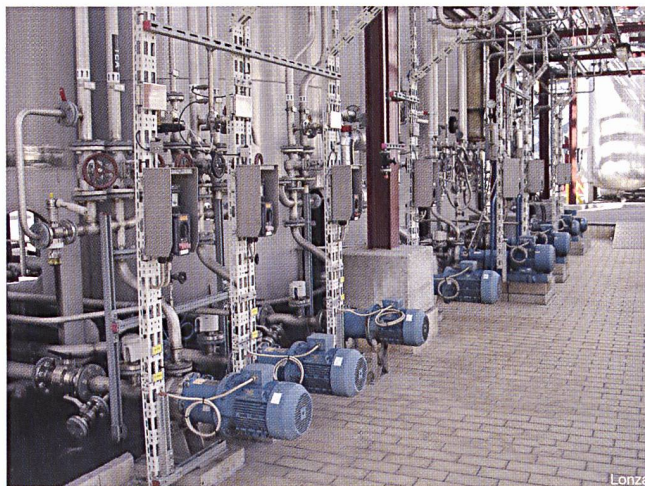
Bild 2 Hauptkonsument: Elektromotoren Die Lonza verbraucht jährlich 400 GWh Strom. 94% davon fließen in Elektromotoren, die vor allem Pumpen und Kompressoren antreiben.
