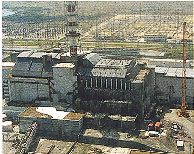
Tschernobyl IV: La dégradation du sarcophage en ciment est préoccupante (photo IAEA).
