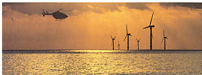
Offshore-Windkraftanlage (Bild Repower).
