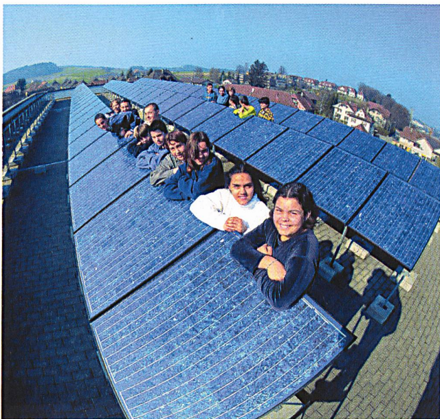
Immer noch hohe Wachstumsraten bei der Photovoltaik (Bild Swissolar).
