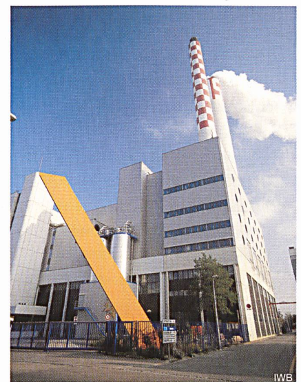
Bild 1 In der KVA wird neben Wärme auch Strom erzeugt. Die Ausdehnung des Fernwärmenetzes ist ein Ergebnis der energiepolitischen Wende in den 1970er Jahren. In absehbarer Zeit wird die Wärme-Produktion durch ein Holzkraftwerk ergänzt.
