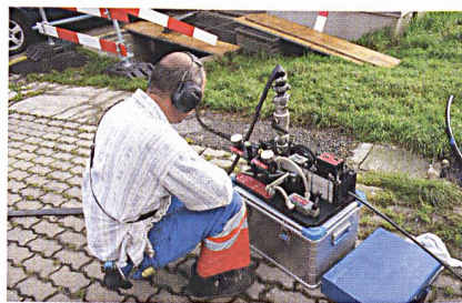
Ein Mitarbeiter der EKT AG überwacht das Einblasen der Glasfaserkabel (Bild: ekt).
