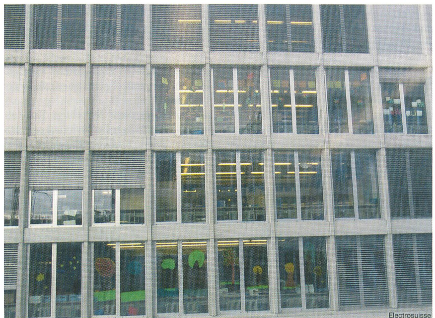
Bild 1 Schulhaus Birch: Auch bei diffusem Tageslicht sind 500 Lux schnell erreicht – die Beleuchtungsreihe am Fenster schaltet dementsprechend früh aus.
