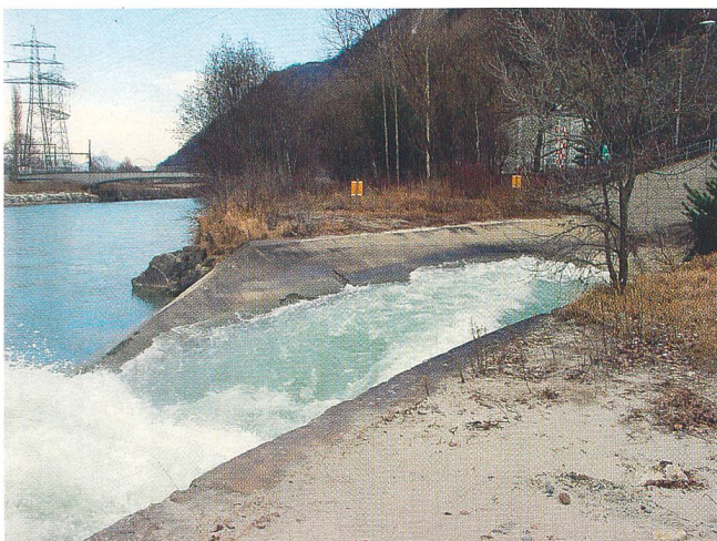
Ausfluss der Zentrale Nendaz der Grande Dixence (Bild Eawag, M. Fette).
