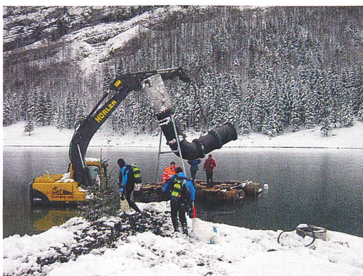
Installation der neuen Druckleitung am Seelalpsee (Appenzell) November 2004 (Bild Iteco).
