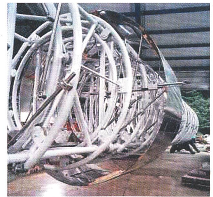
Le gabarit en cours de montage.
