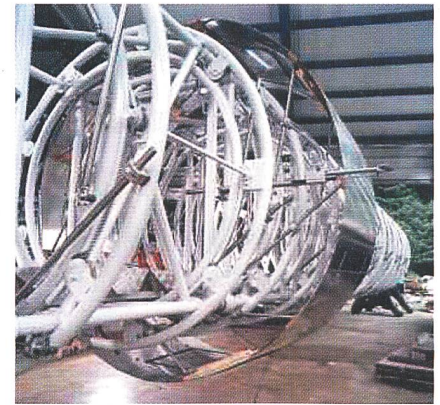
Le gabarit en cours de montage.
