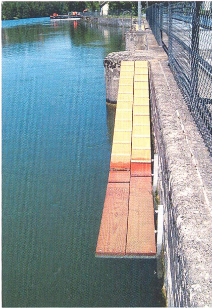
Bild 3 Drei neue Rampen ermöglichen es den rheinabwärts wandernden Bibern, beim Wasserkraftwerk Laufenburg ans Ufer zu steigen und das Kraftwerk auf dem Landweg zu umgehen.
