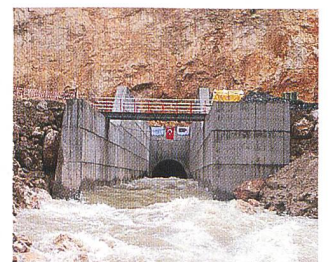
Aushubarbeiten für den Ermenek-Damm in der Türkei.
