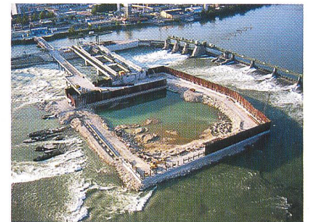
Baugrubenumschliessung der zweiten Baugrube wurde im November 2005 abgeschlossen. Die Baugrubenumschliessung sowie die neue Rampe für die zweite Baugrube sind fertig gestellt. Nach Abschluss der Injektionsarbeiten konnte mit dem Ausbruch des Muschelkalkfelsens noch im Dezember begonnen werden. Danach kann die Bodenplatte für die nächsten drei Wehröffnungen vorbereitet werden (Bilder: energiesdienst).
