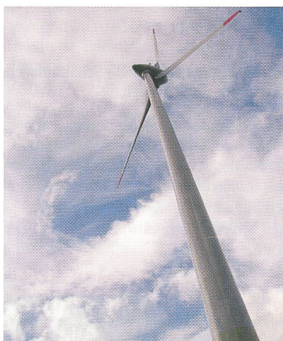
Im Unterwallis steht die grösste Windturbine der Schweiz. (Bild: KohleNusbaumer)
