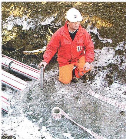
Inaugurato il cantiere della Mendrisio-Cagno.
