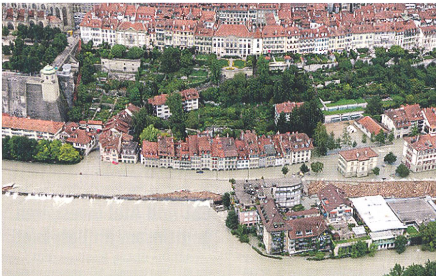
Überschwemmung beim Kraftwerk Matte in Bern letzten August (Bild: Luftwaffe).
