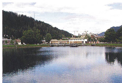
Der Doggilochsee dient als Kompensationsbecken nach der Turbinierung des Wassers im Kraftwerk Klosters (Bild: repower.ch).
