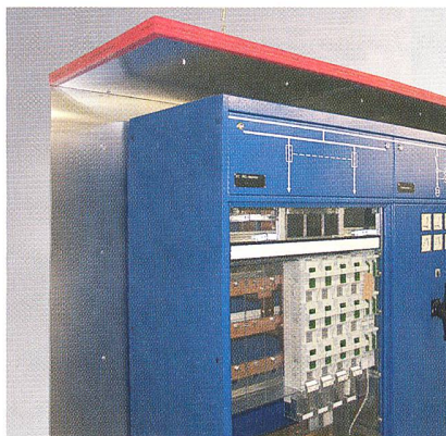
PowerMan-Abschirmung von CFW zum problemlosen Nachrüsten von Energieverteilungen
