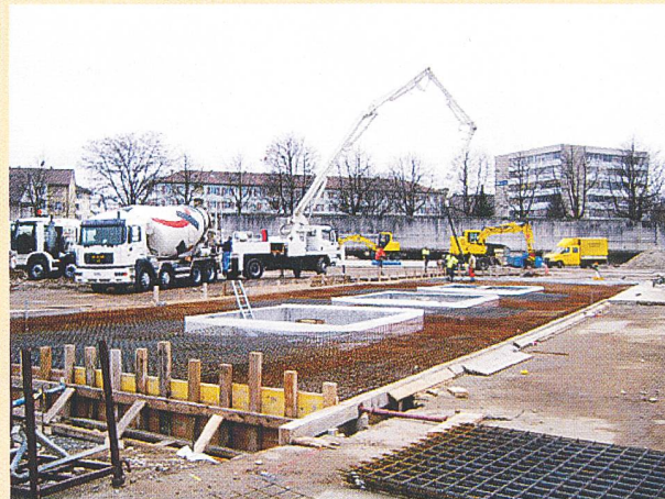
Bohrplatzvorbereitungen in Kleinhüningen/Basel (Bild Geothermal Explorers).
