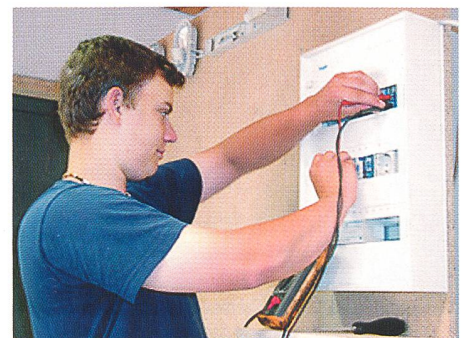
Elektriker: Gefahren auch ausserhalb des Stromnetzes.
