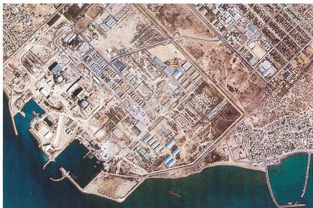
Gelände der umstrittenen KKW-Anlage Bushehr.
