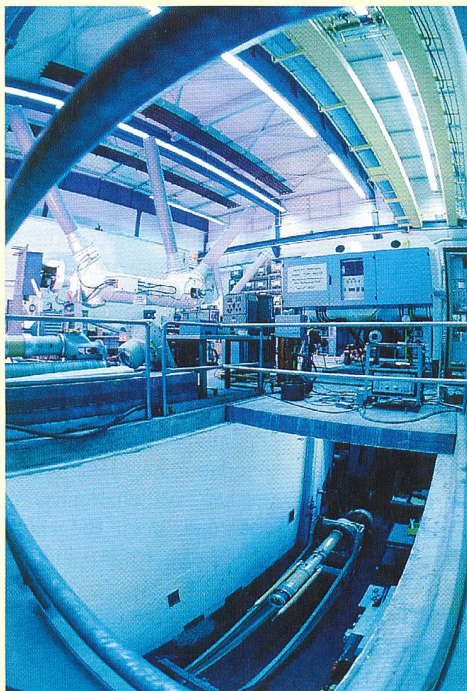
ABB: stark in Energie- und Automationstechnik (mechanische Werkstatt in Zürich-Oerlikon).
