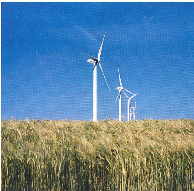
2005 wurden weltweit 10 000 MW Windkraft installiert (Bild Fuhrlaender/bwe).
